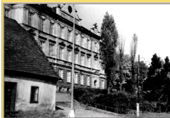
Budova školy v září 1970 a po zahájení generální opravy v roce 1975
